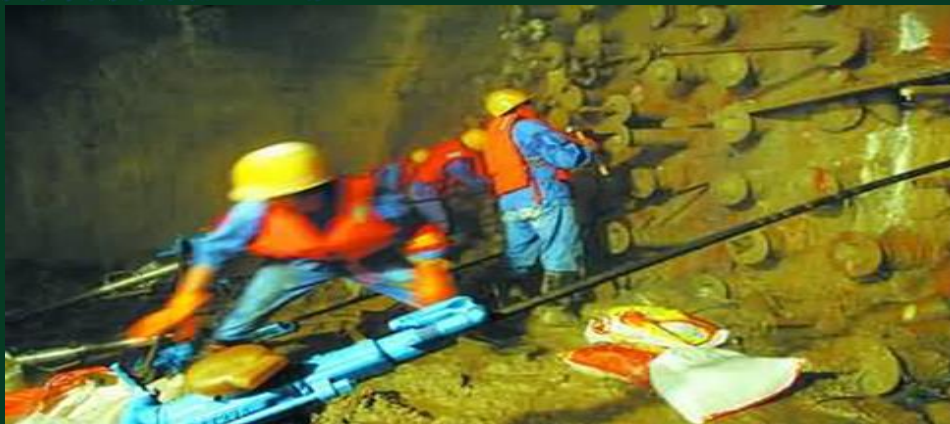
厦门翔安隧道风化槽
